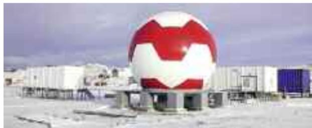
Станции спутниковой связи предназначены для передачи информации от беззапросных измерительных систем, необходимых для уточнения положения спутников в космосе и определения задержек сигналов от них. Это помогает повысить точность геопозиционных данных в глобальной навигационной системе.
