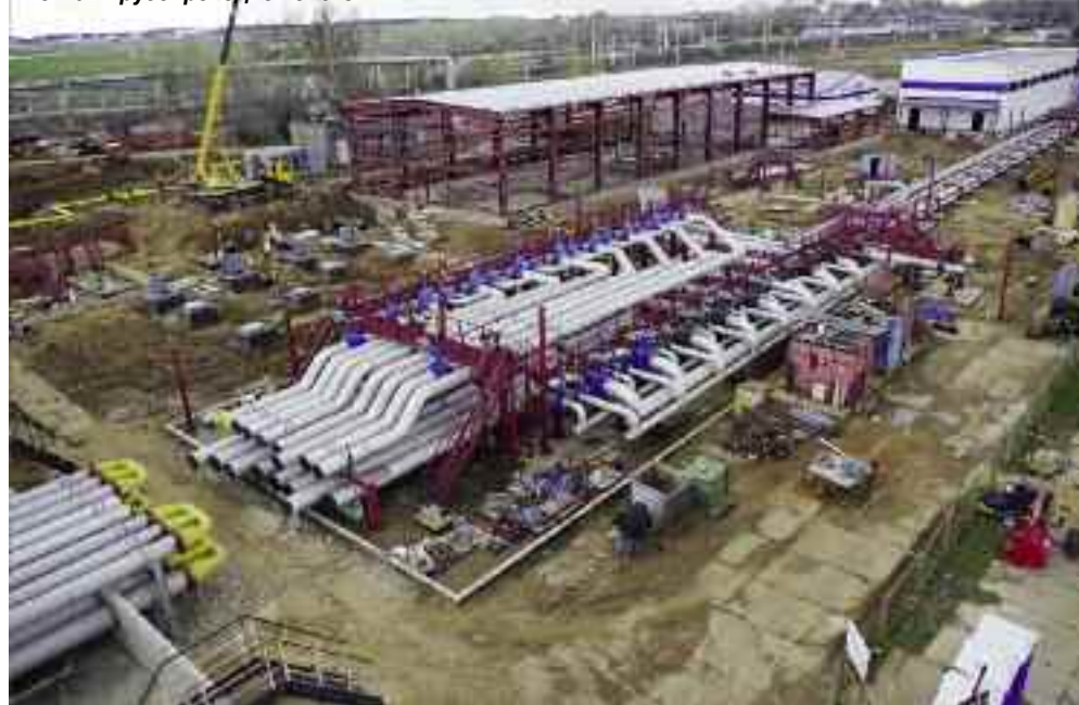
Монтаж трубопроводной системы
